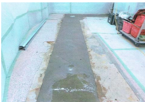
埋戻し・土間コン打設
