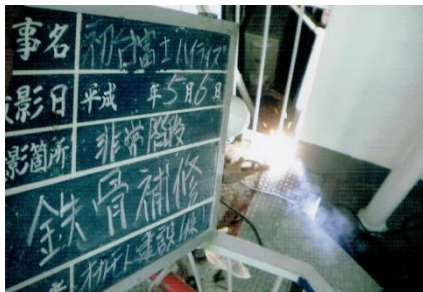
新規鋼板溶接
