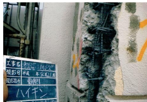
補強鉄筋組立
