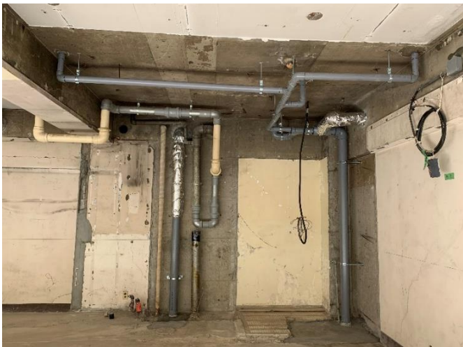
鋳鉄排水管を塩ビ排水管に交換する 壁をはさんで両側の部屋から工事し、梁貫通部の鋳鉄管も交換する
