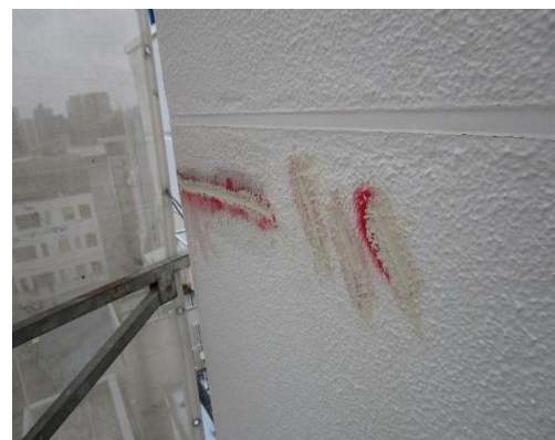
クラック補修
