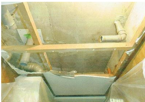
排水管交換前
