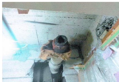
既存排水管切断
