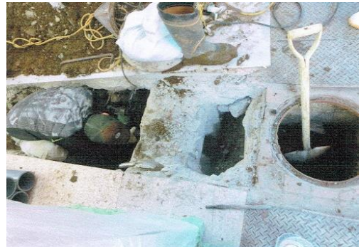
既存排水管撤去
