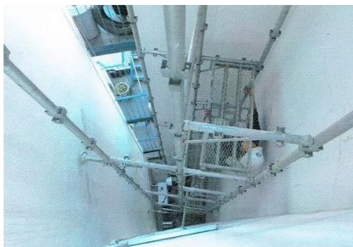
外部足場組み
