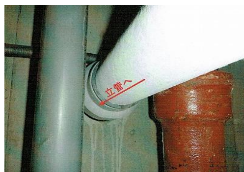
新設縦管に接続
