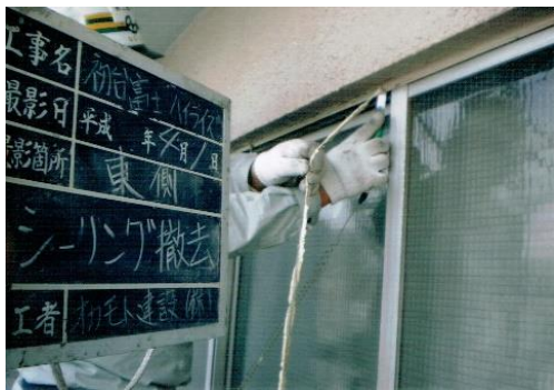
旧シーリング除去
