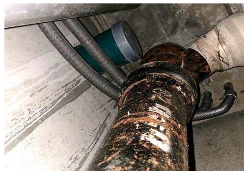
既存PS内新設配管突出し
