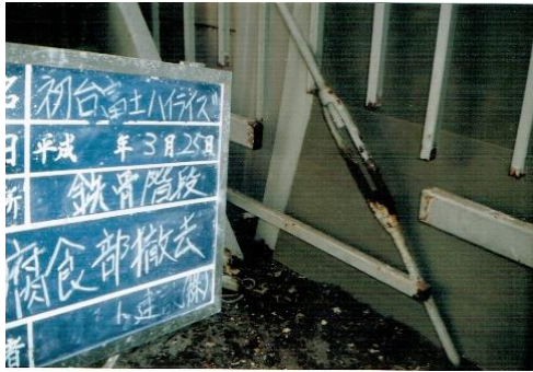
鉄骨腐食部除去
