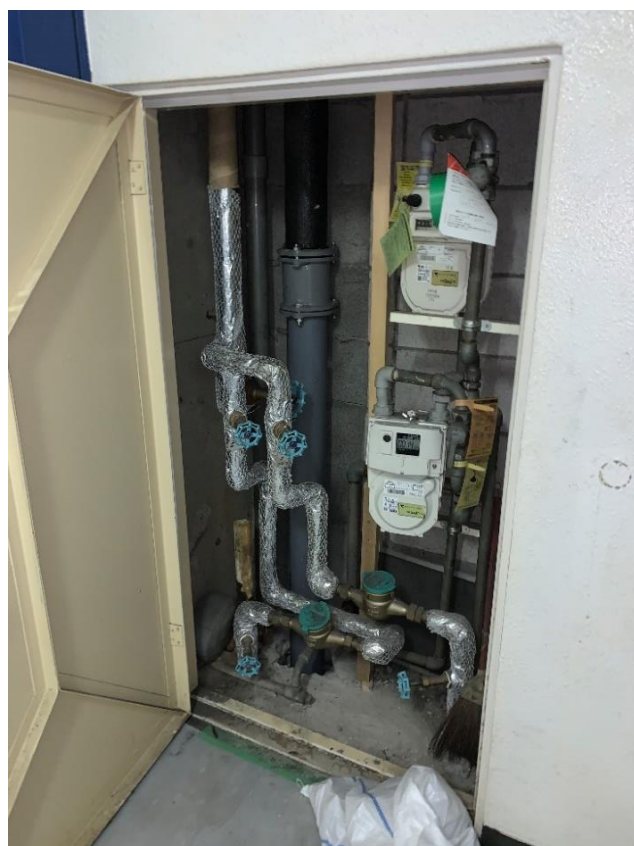
排水鉄管を塩ビに交換
