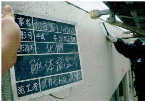
外壁浮き打診調査
