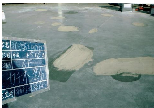
劣化部分補修
