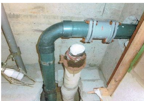
新設排水管に切替
