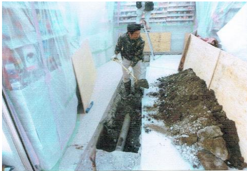
1階床下排水管掘り起こし
