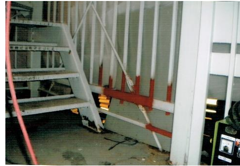
新規部材溶接
