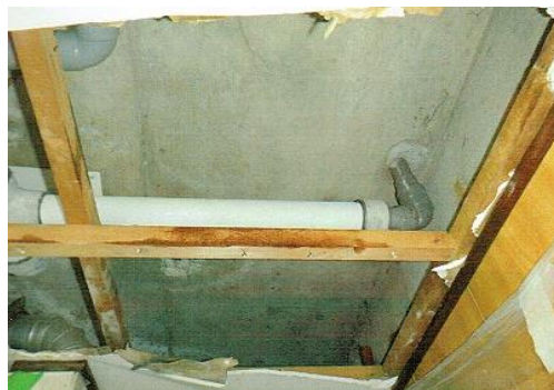
排水管交換後
