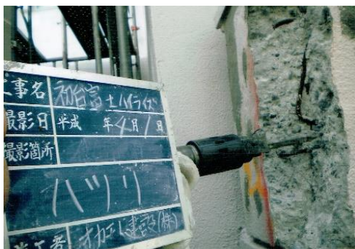
脱落部分はつり
